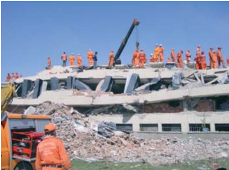
Resim 1 - Çeltiksuyu YİBO Pansiyon Binasının Yıkılma Görüntüsü
